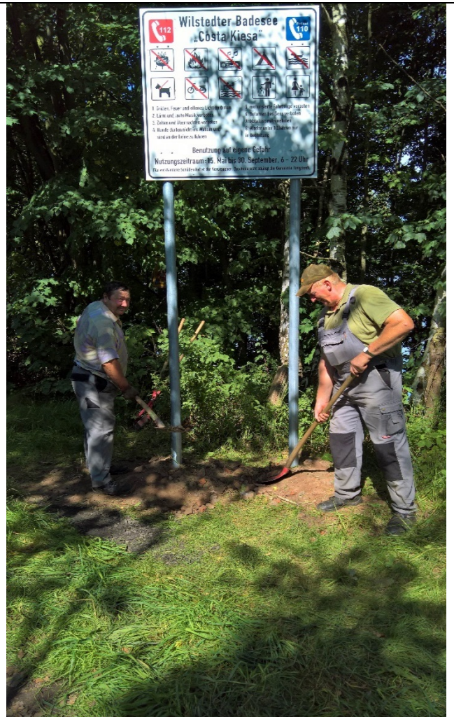
Mitarbeiter des Bauhofes bei der Aufstellung der Tafeln mit schwierigen Untergrund
